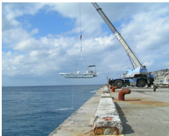
写真 1-2 クレーンで漁船を吊り上げる様子
