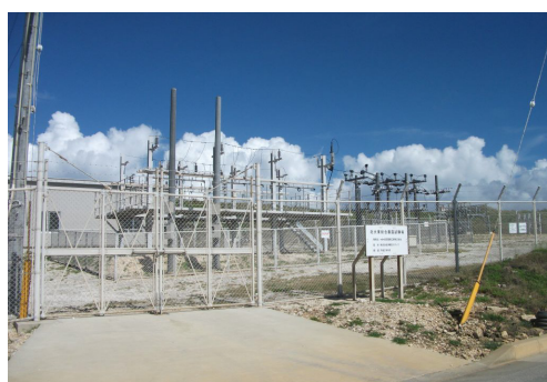
写真 4-11 暴露試験実験施設
