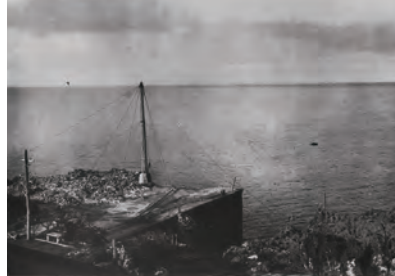
建設当初の西港
