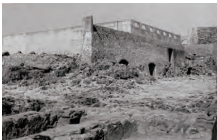
戦後に改造されたコンクリート製の貯蔵庫
