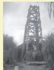
ボーリング調査風景
