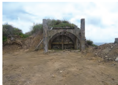
貯蔵庫東側のろうとを支えた コンクリート構造物
