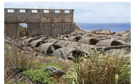
米軍が機械化に対応するために 穴を開けた貯蔵庫のトンネル
