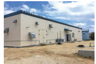
海水淡水化施設
