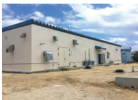
海水淡水化施設
