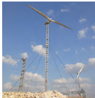
南大東島可倒式風力発電
