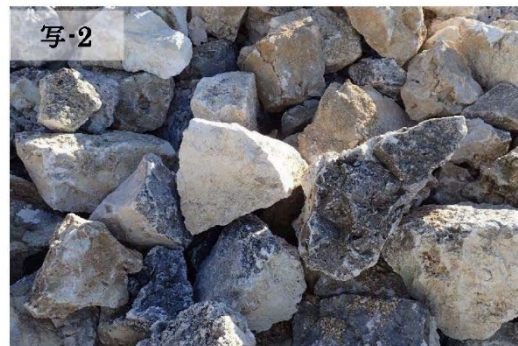
崩落石材集積状況；面と控長が同程度の石材が多くみられる
