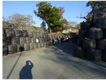
見学導線上の安全対策(土のう)
