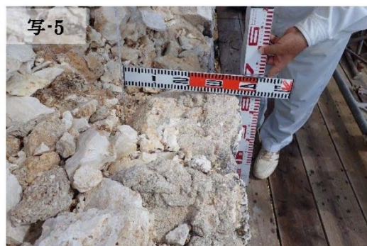
控え検測している状況；控え 350mm
