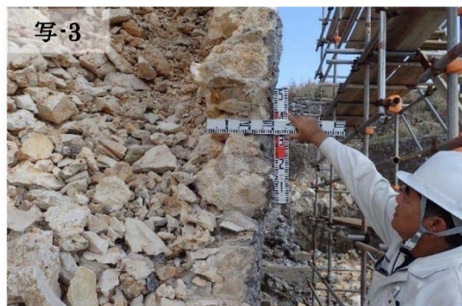
控え検測している状況；控え 300mm
