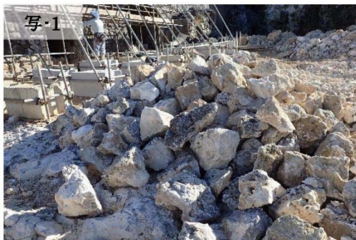
崩落石材集積状況；面と控長が同程度の石材が多くみられる
