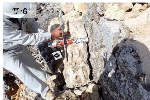
控え検測している状況；控え 350mm
