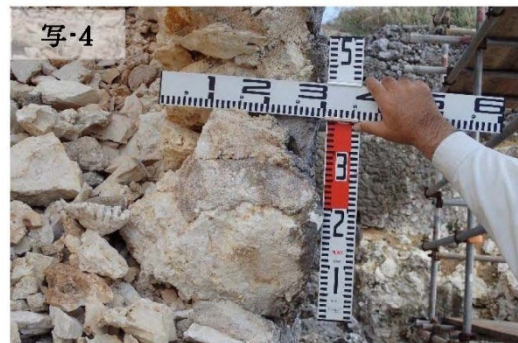
控え検測している状況；控え 300mm
