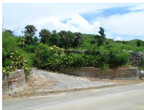
図 9-34 所長住宅跡外構（左：ドロマイト石積、右：門柱及び外構）
