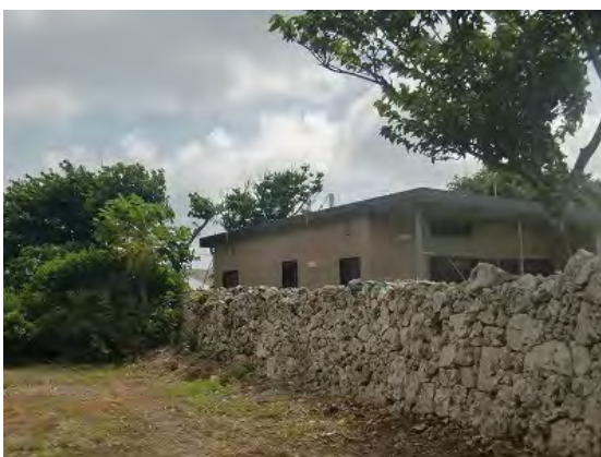
図版 9-63 修復されたドロマイト石垣
