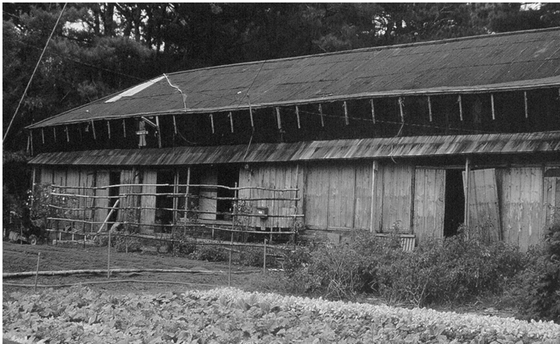
図版 9-41 大正期に建設された教員住宅
