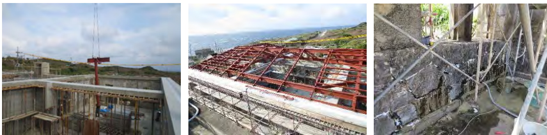
図版 9-9 りんこう交流館（北大東島出張所跡）復元工事写真
