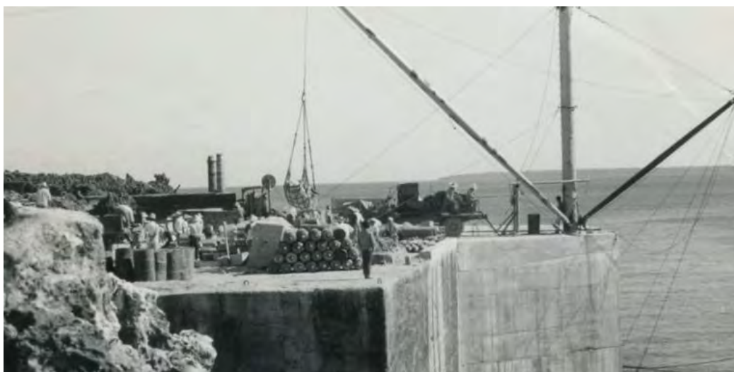
図版 6-16 アメリカ船のマストを利用したクレーン
