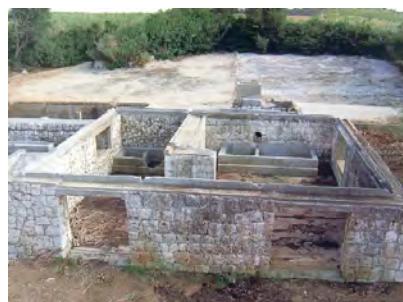
図版 8-48 下坂共同浴場の取水場
