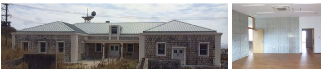
図版 9-10 りんこう交流館（北大東島出張所跡）復元後の写真（外観、内観）
