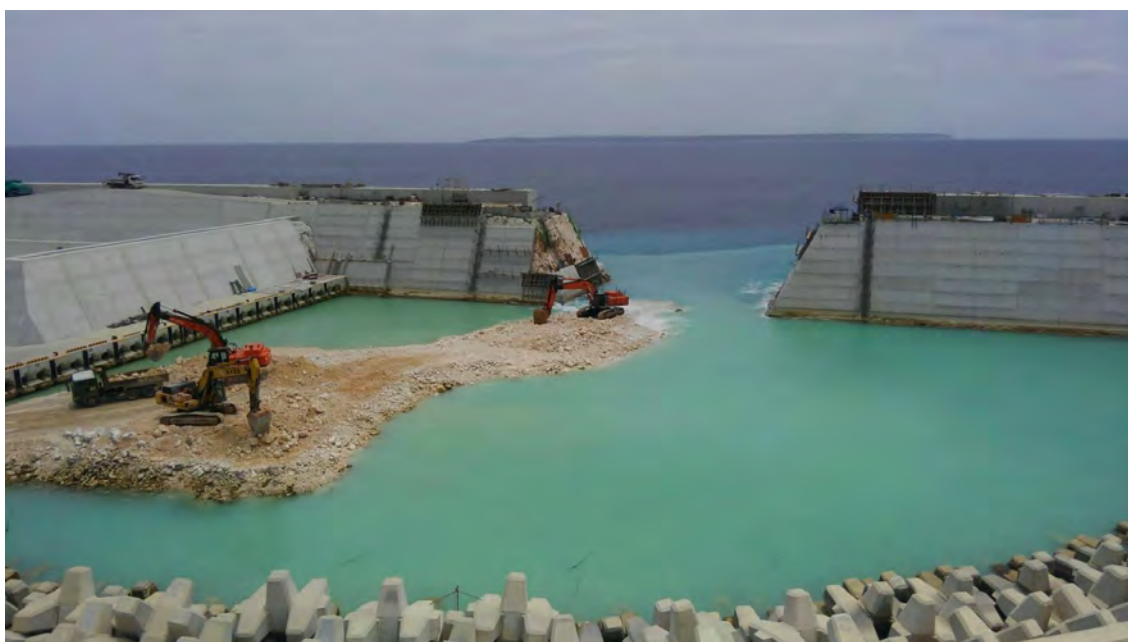
図版 6-21 漁港の工事写真
