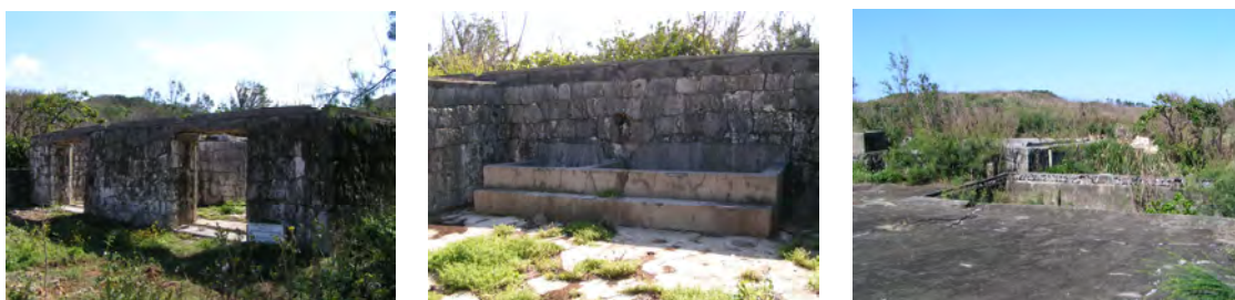
図版 9-75 現在の下坂大衆浴場遺構の現状写真
