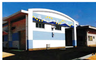
図版 8-5 海水淡水化施設
