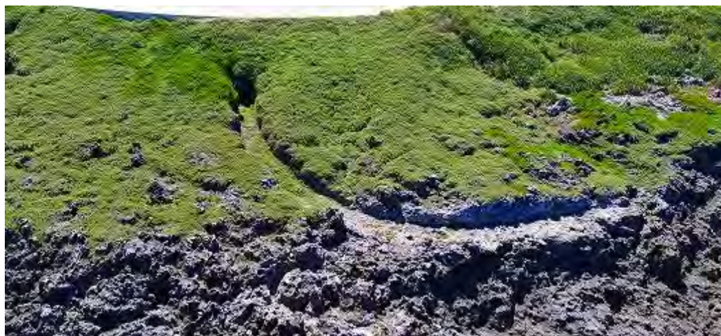
図版 9-82 黒部トンネルの現況写真
