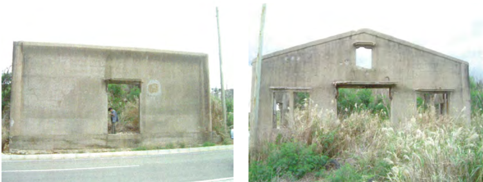
図版 9-18 福島調査写真：発電所
