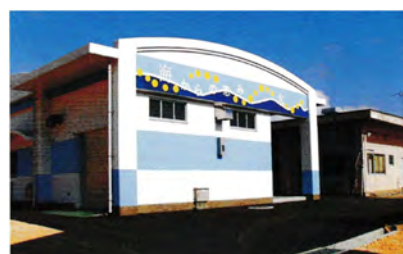
図版 8-49 海水淡水化施設
