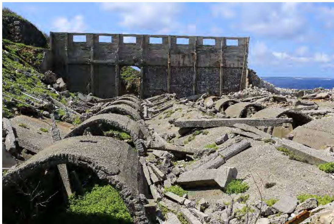
図版 5-11 米軍により割られた燐鉱石貯蔵庫のトンネル上部
