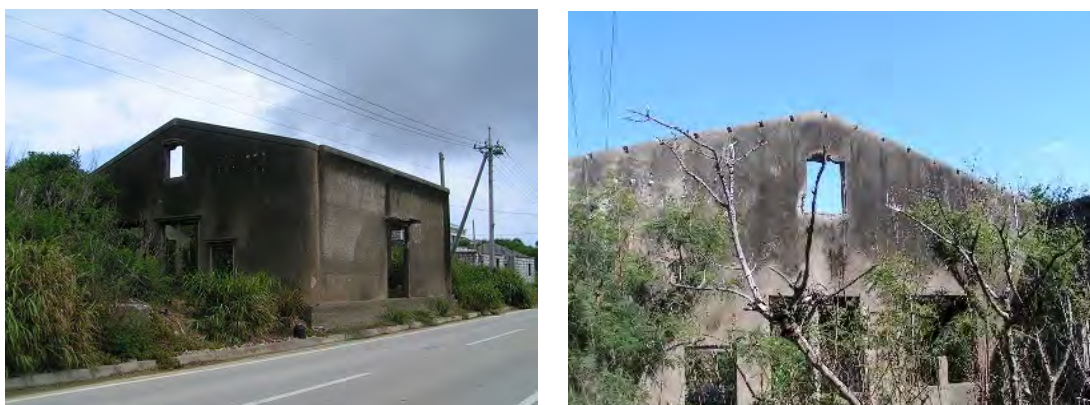
図版 9-19 発電所遺構の現状写真
