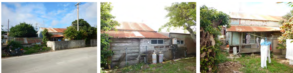
図版 9-52 社宅遺構⑤（改修前）外観
