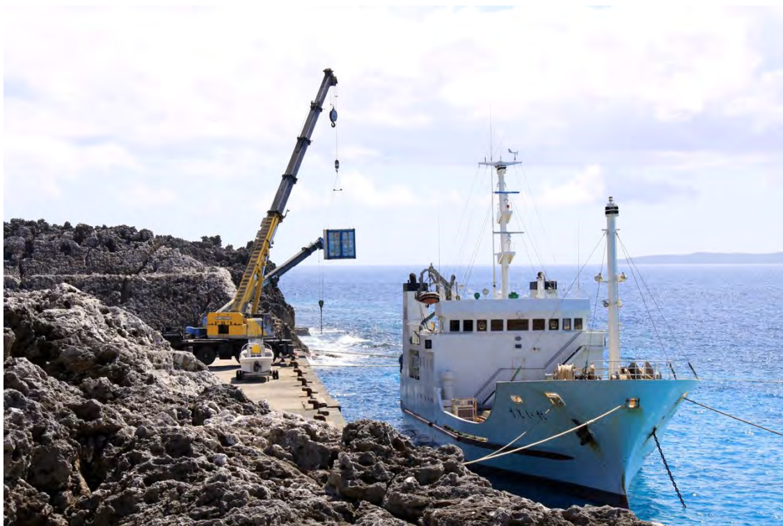
図版 6-23 移動クレーン車による荷役
