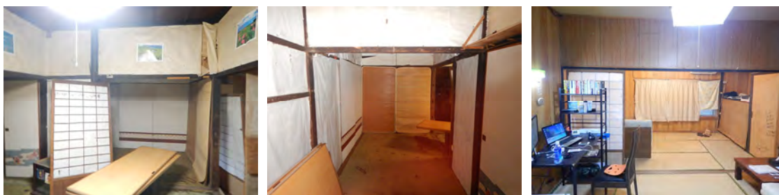
図版 9-53 社宅遺構⑤（改修前）内観
