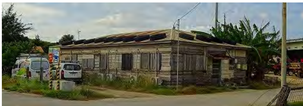
図版 9-30 敷地跡に建てられた診療所遺構
