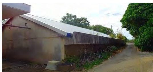
図版 8-3 字南共同タンク
