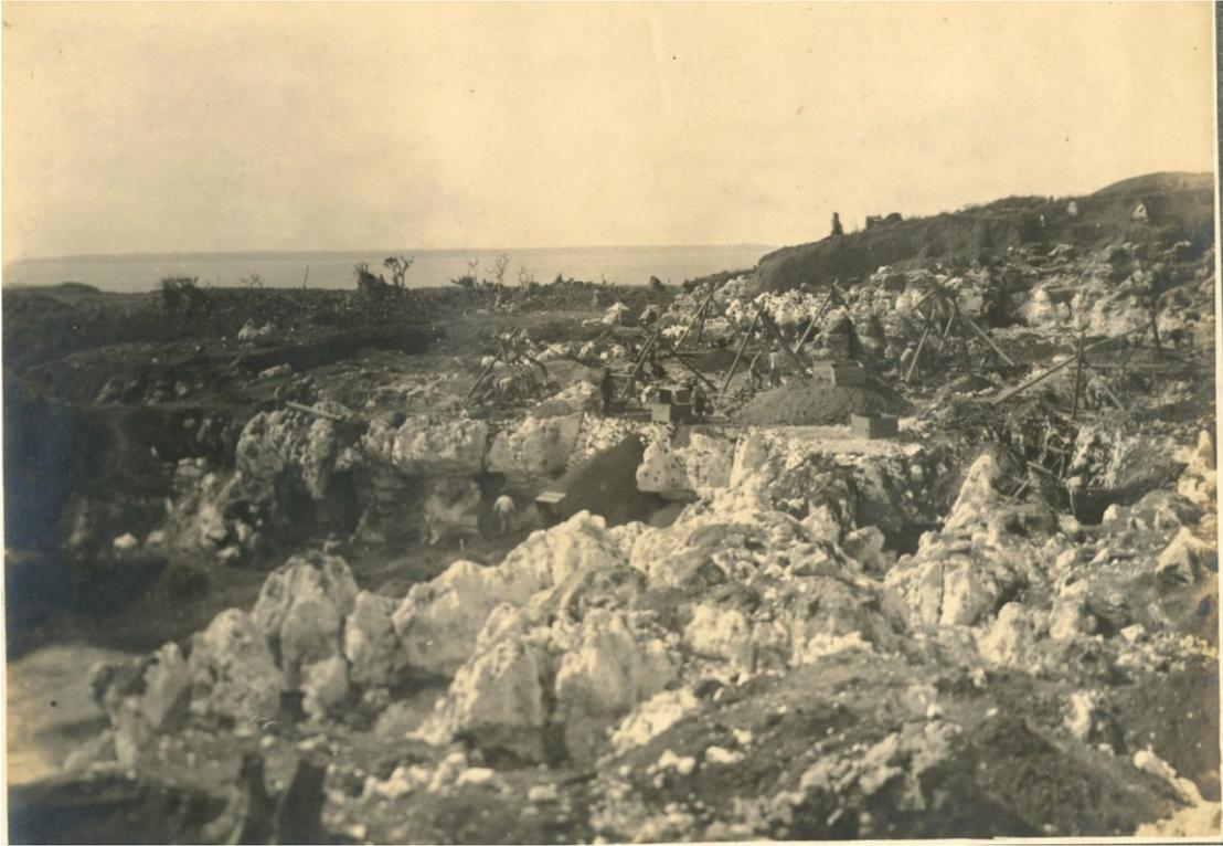
図版 17-④ 黄金山付近の採掘の様子。石灰岩の間の燐鉱を掘り進んでいるのが分かる。
