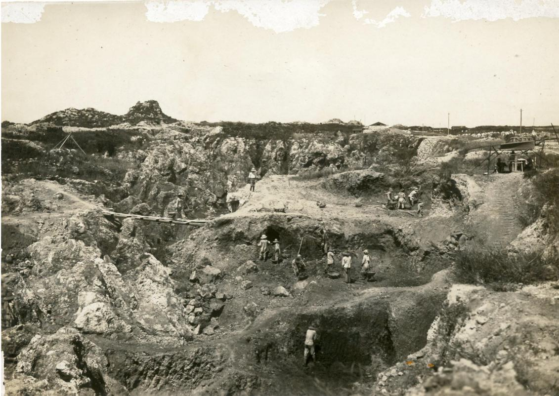
図版 17-⑥ 階段式露天掘り。右上に鉱夫を監督する社員のテントが見える。
