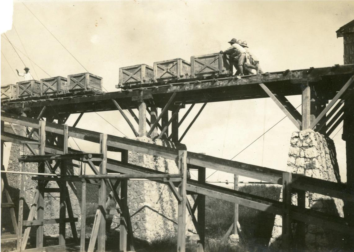
図版 19-⑥ 乾燥を終えた燐鉍石を貯蔵庫に運び入れるためのトロッコ橋。(大正後期)
