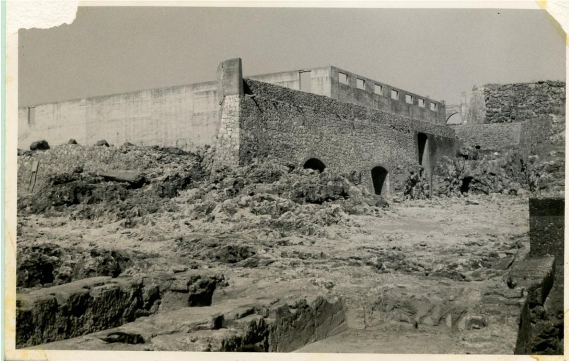
図版 19-⑪ 戦後の貯蔵庫。戦時中に爆撃で大破したが、内部にコンクリートで建屋をつくり、海側のトンネルは利用しなかったと考えられる。米軍により、トンネルが割られた際にも、海側のトンネルのみが無傷である。
