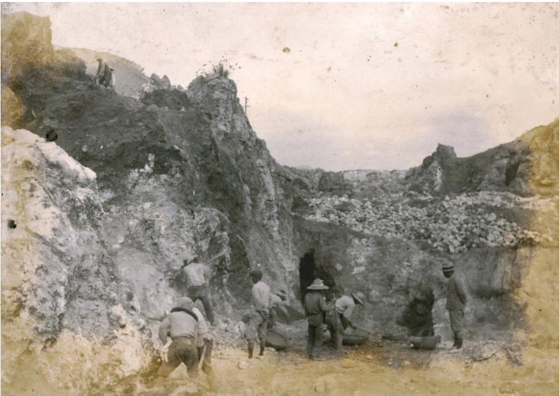
図版 17-⑪ ツルハシ、ジョレン、バイスケによる手作業で行った採掘作業。
