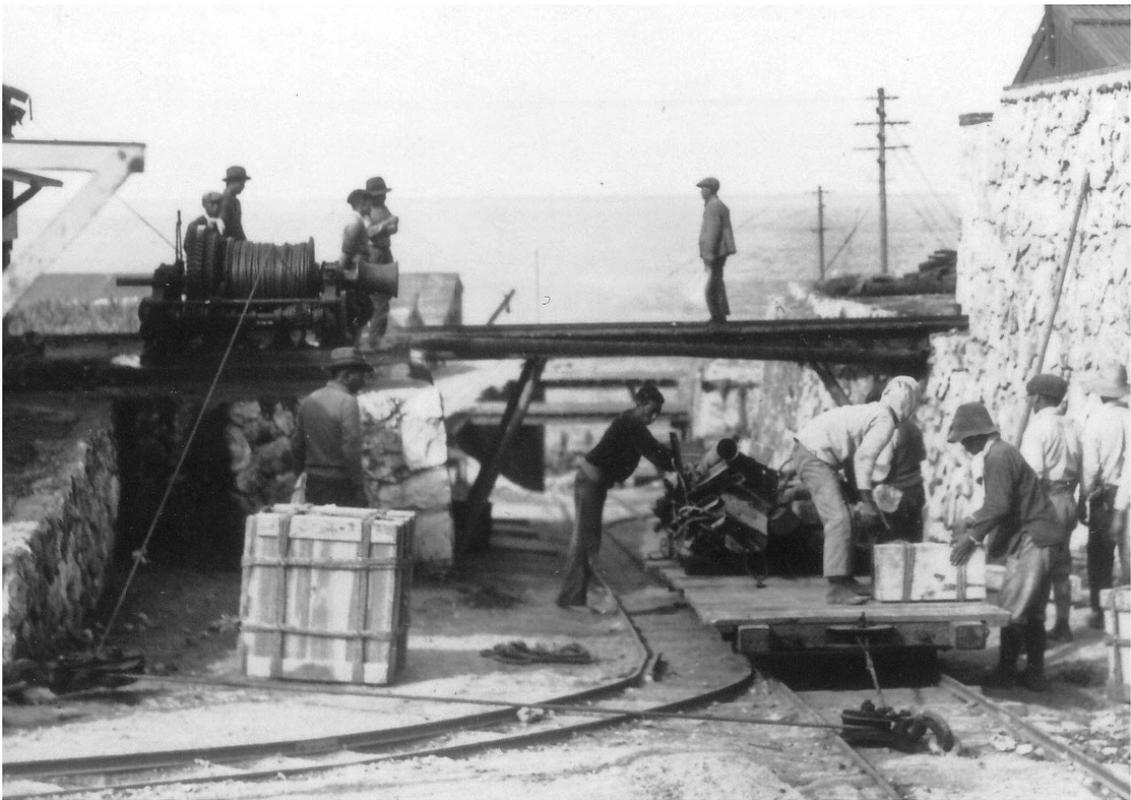
図版 19-⑤ 荷役風景の向こうに、貯蔵庫（左）とドライヤー建屋の間に2つの橋が渡されてるのが見える。乾燥された燐鉍石がこの橋を通過して入庫された。（大正後期）
