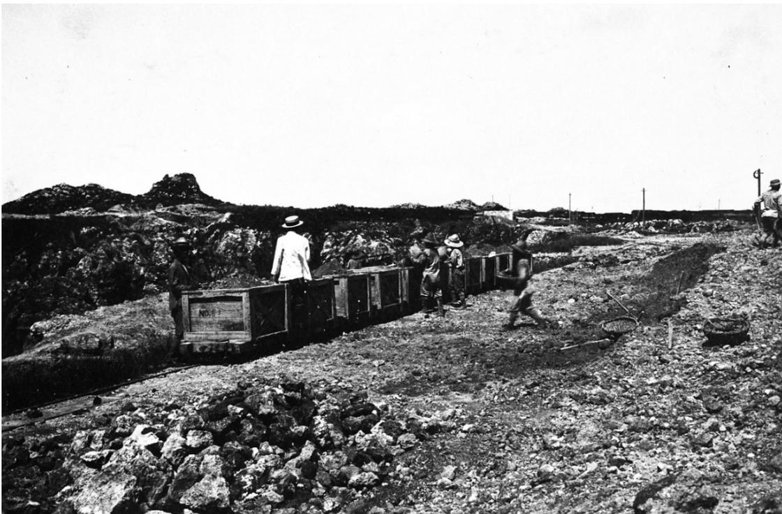
図版 18-② 軌道沿いに堆積された燐鉍石をトロッコに積む様子。(大正後期)
