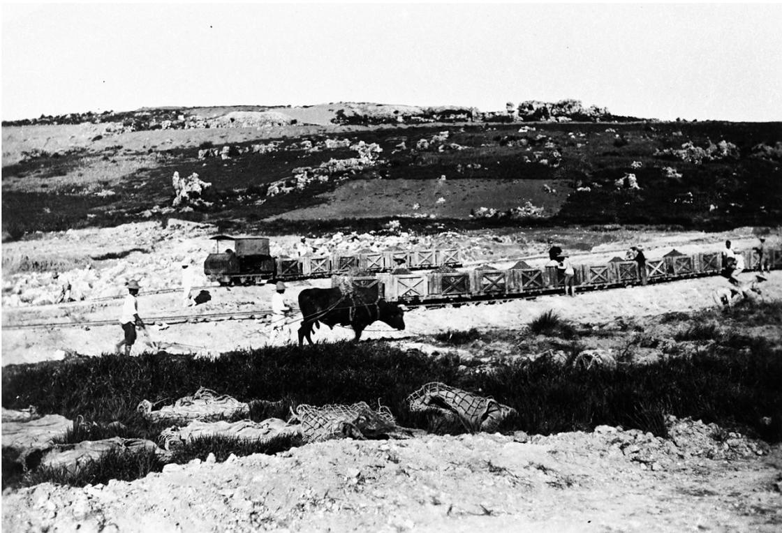
図版 18-① 燐酸礬土鉍は多量に水分を含んでいるため、地面に広げて、牛の力ですき起こして乾燥させた。遠景にガソリン機関車が牽引するトロッコが見える。(大正後期)
