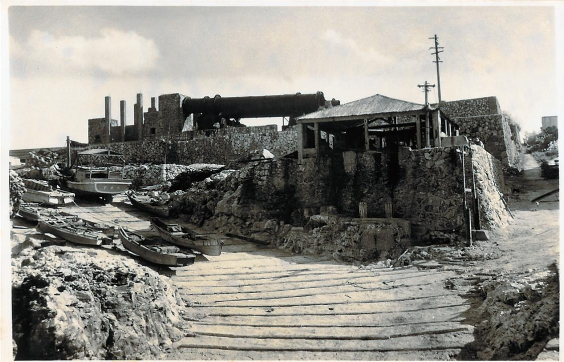
図版 21-③ 戦後、建屋が失われ、むき出しになったドライヤー。左に耐火煉瓦の炉が見える。(大正後期)
