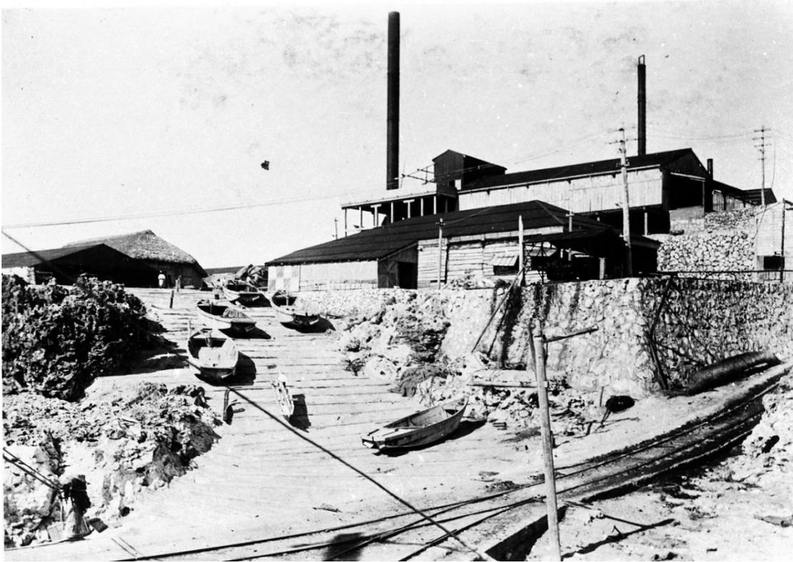
図版 24-① 舢の揚げ降ろしに用いられた船揚げ場の斜路。左に舢倉庫と造船場、右に巻き揚げ機。奥に、倉庫、ドライヤー建屋。(大正後期)
