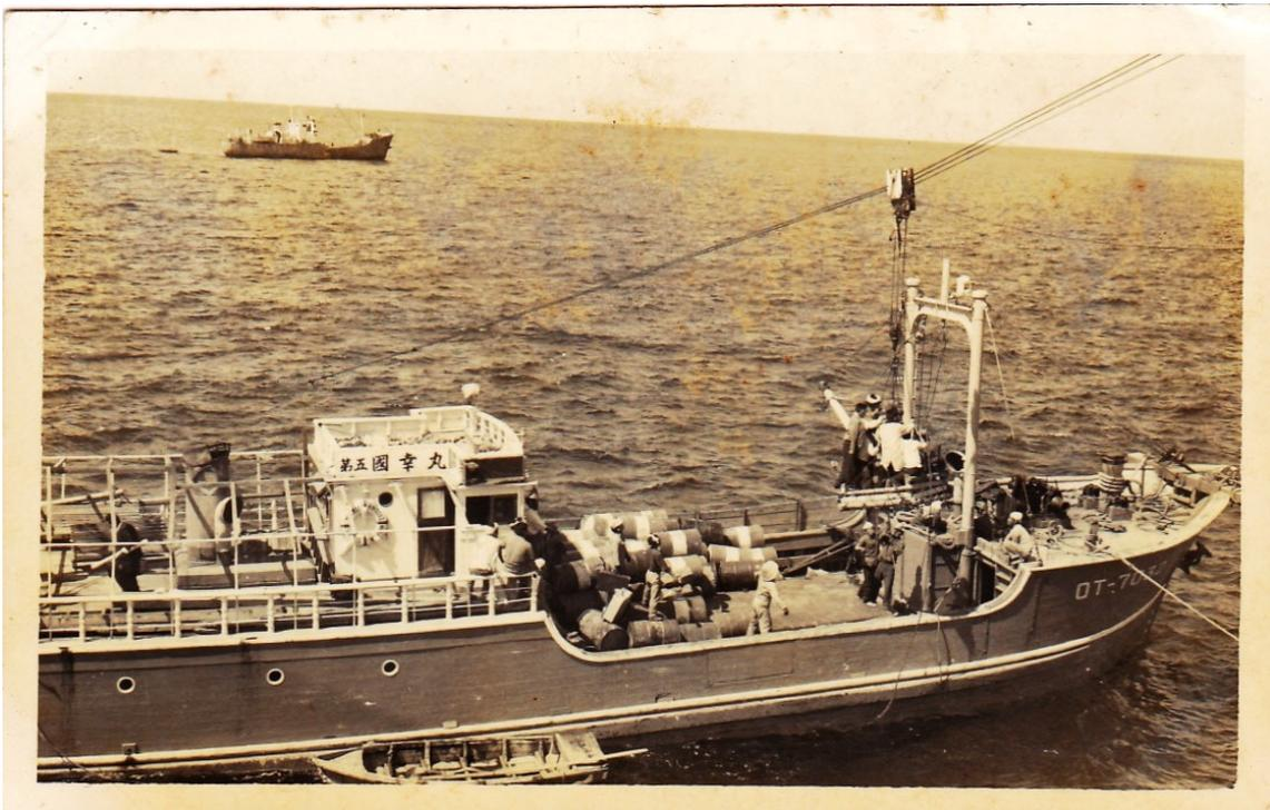
図版 23-④ 昭和 30 年代には、陸上と沖合をワイヤーロープで結び滑車により荷役を行う方法も使われた。（昭和 38 年頃）
