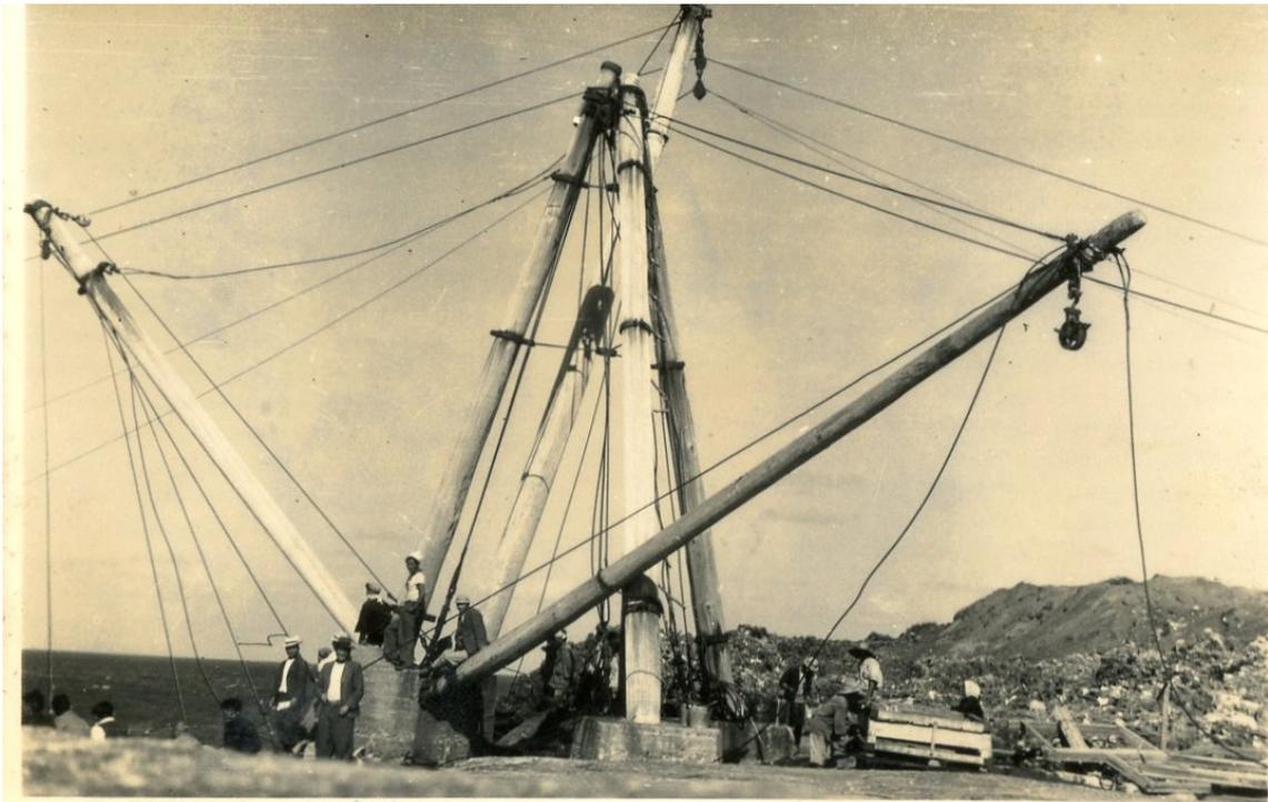
図版 23-③ 大日本製糖の経営時に使われた三本の丸太を組み合わせたデリック。戦後、昭和 31 年まで使用された。（昭和 31 年頃）
