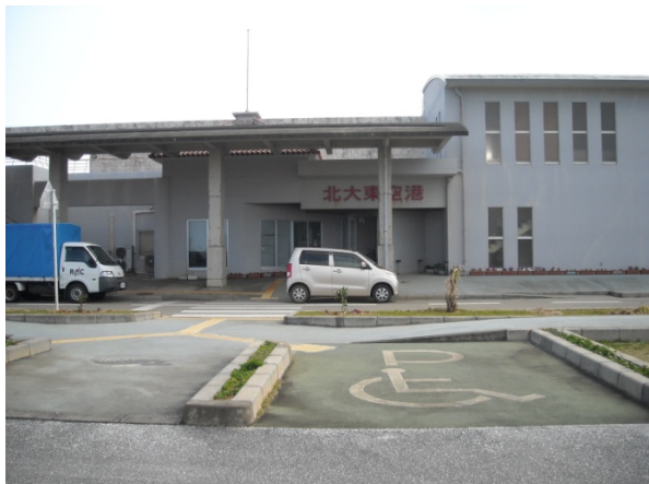
駐車場の植栽帯の樹木が折れている
