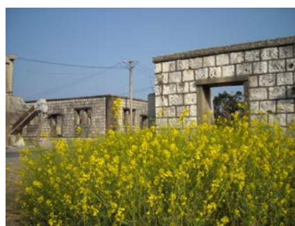
ドロマイトの外壁
