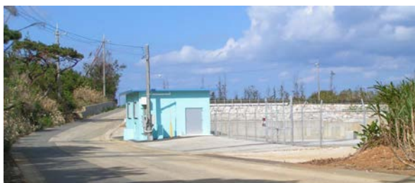
農業用水池とポンプ室 1
