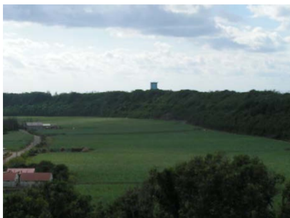
斜面緑地の上に立つファームポンド
