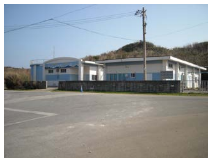
海水淡水化施設
