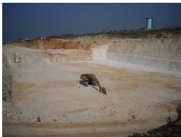
工事中の北大東漁港
