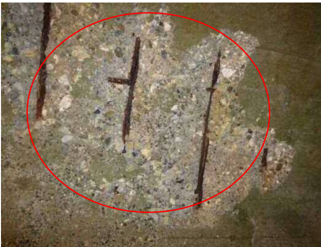
現況④ 鉄筋爆裂部の劣化補修
