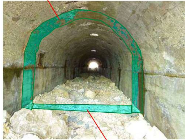
現況③ 土間の設置
