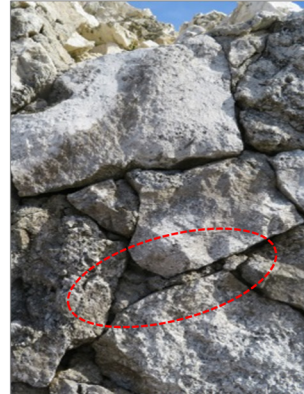
目地モルタル写真 写真3
