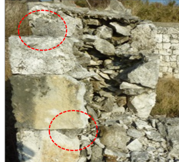
写真6の拡大 ○囲みがモルタル 写真
