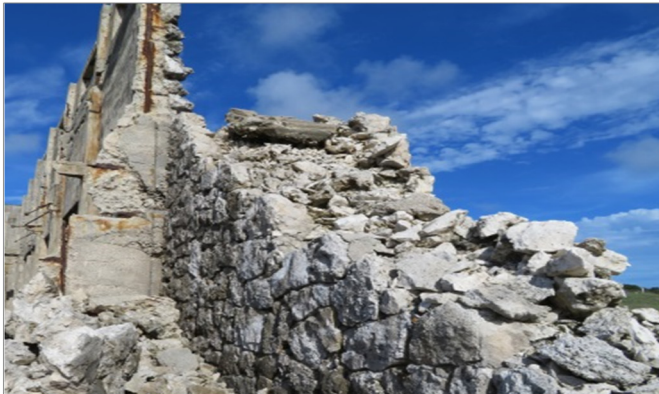
緊急保存措置対象の石積み壁 写真2
