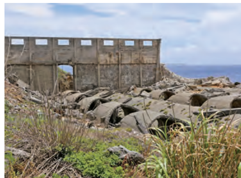
割られた貯蔵庫あとのトンネル
