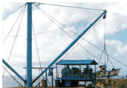
マストクレーンによる荷役 (昭和50年ごろ)
