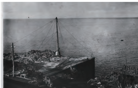
戦前の西港(完成したころ)
