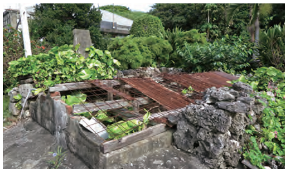
使っていない家庭の水タンク
